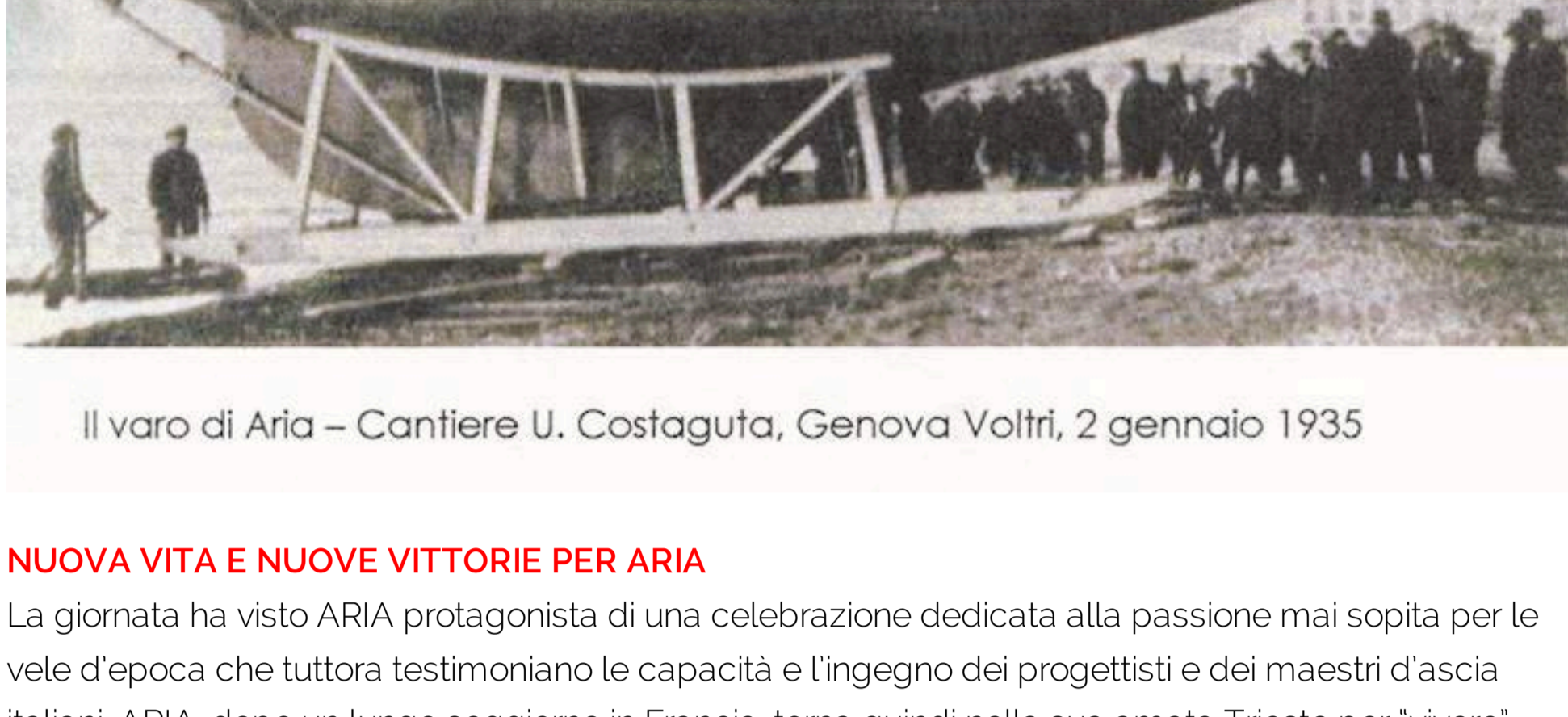
Il varo di Aria - Cantiere U. Costaguta, Genova Voltri, 2 gennaio 1935
